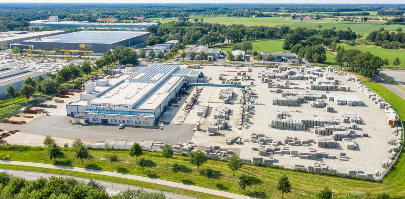
Productielocatie Swaans Beton
